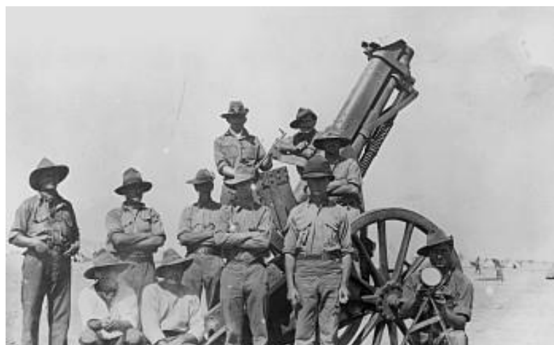
Le canon anti-aérienne Skinny Liz, un BLC 15 pounder modifié notamment pour tirer jusqu'à un angle de 60°, sous les ordres du Lieutenant E.H. Tomplin et déployé à Tschaukaib début 1915. Source : SAAF Museum.
